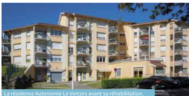
La résidence Autonomie Le Vercors avant sa réhabilitation.
