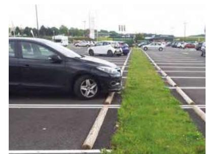
Principe de stationnements drainants sur une partie des places de stationnement. Principe de traitement en noues drainantes de toute ou partie des eaux pluviales.
